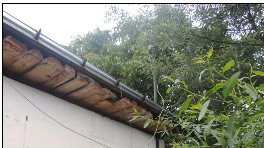
Fig. 4. Imaginea în care se observă cum vegetația creează o punte între consolă și acoperiș
